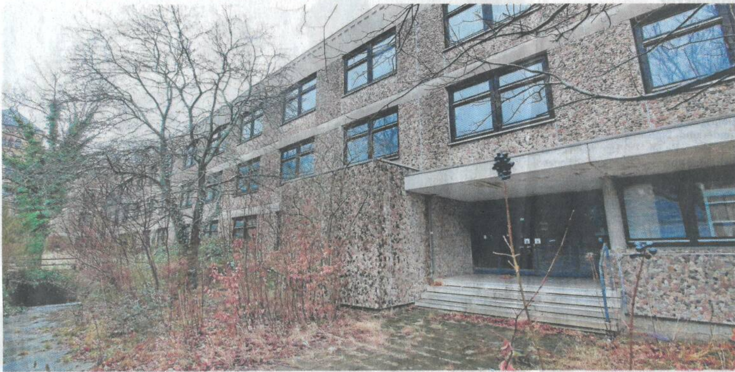
Der Waschbeton hat bald ausgedient: Auf dem Gelände der ehemaligen Bundesgrenzschutz-Kaserne an der Wallstraße entstehen im Pfalzquartier eine Multifunktionshalle, ein Hotel und eine Tiefgarage. Fotos: Epping
