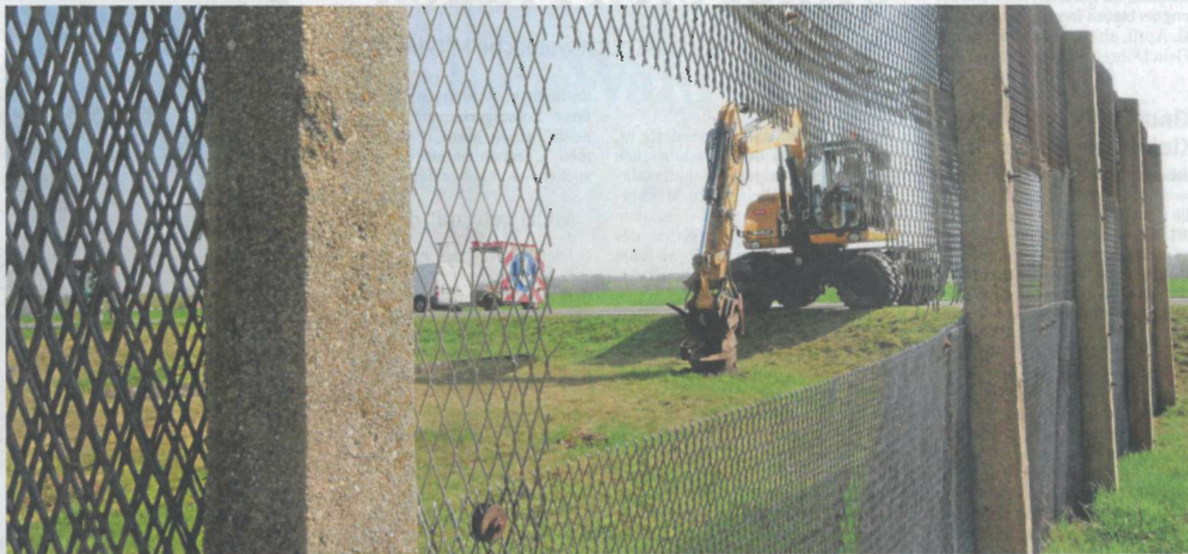
Blick durch ein Loch im DDR-Grenzzaunrest: Vom Bagger aus fräsen die Gartenbauer die Stübenreste ab, was die Pflege des Areals erleichtert.
