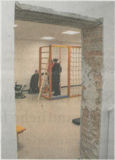
Noch sind die Handwerker zugange.
