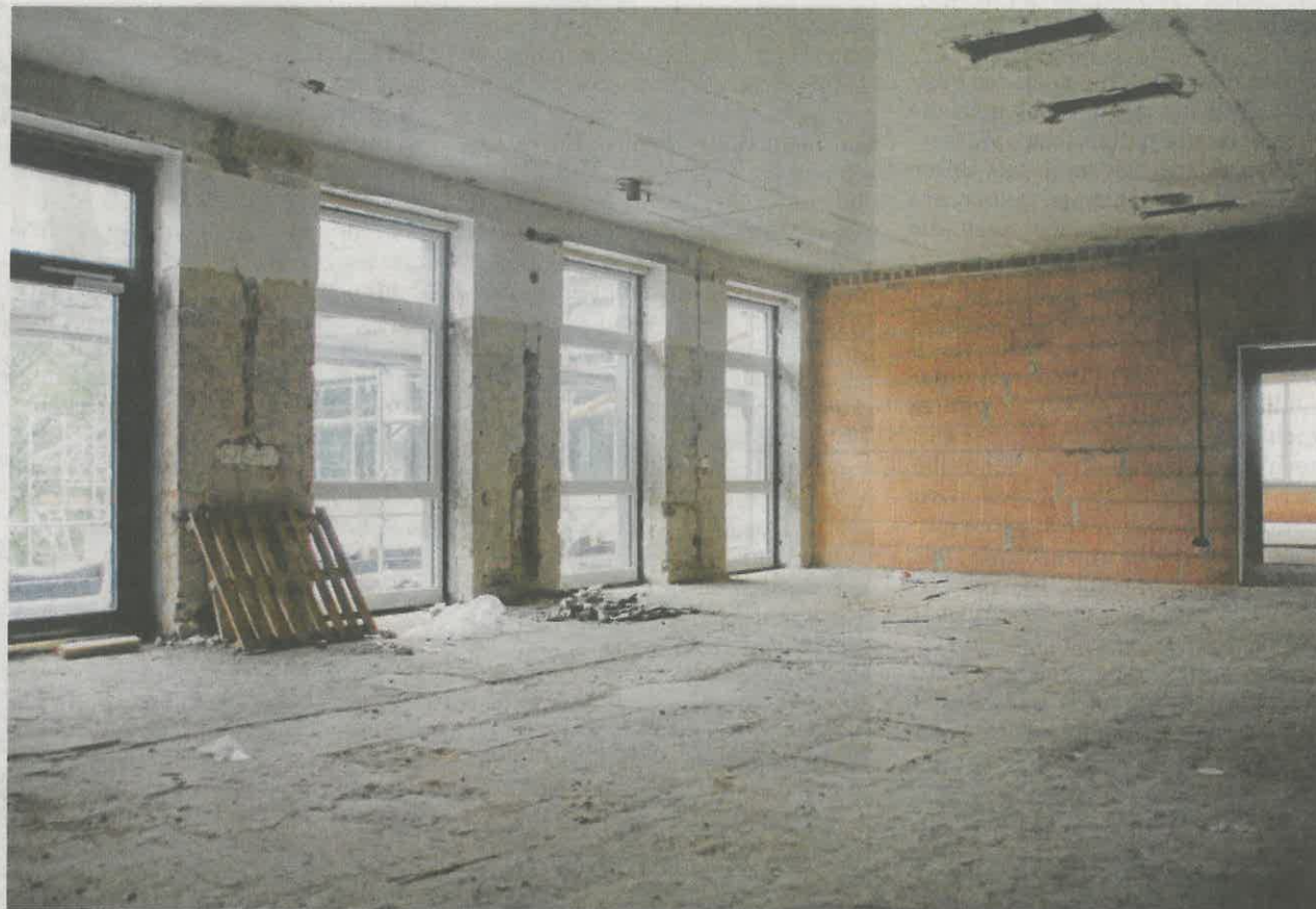
Das Gebäude wurde mit neuen Fenstern ausgestattet. So gelangt mehr Tageslicht in die Räume.
