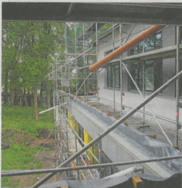
Das Haus liegt in einem Mantel aus Gerüsten. Die Fassade wird mit neuen Dachrinnen und Fallrohren versehen.
